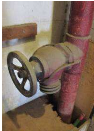
樓宇的消防設施較為簡陋，只有前門的消防入水掣，以及每層梯間的水龍頭。
