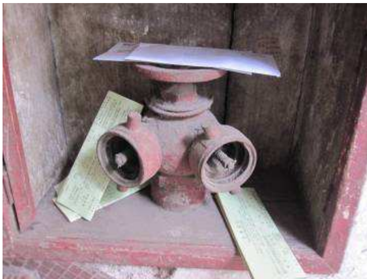
樓宇的消防設施較為簡陋，只有前門的消防入水掣，以及每層梯間的水龍頭。
